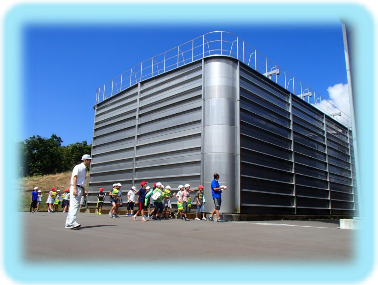
写真:荒川配水場
