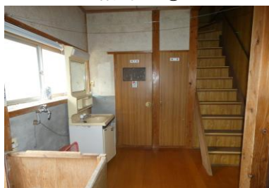
1階 洗面脱衣所
