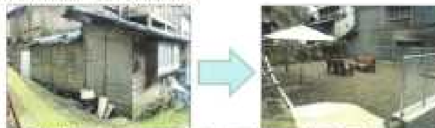
【福井県越前町】老朽化した空き家住宅を除却し、ポケットパークとして活用
