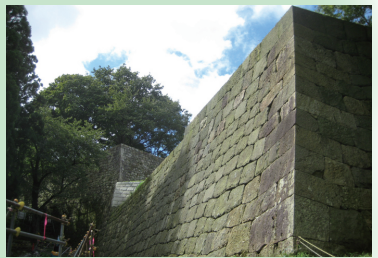
出櫓台竣工時
