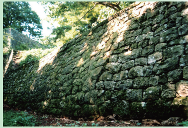
解体前の出櫓台
