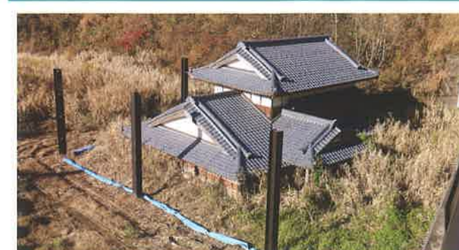
河道閉塞により水没した古籠(こども)集落。たい積した土砂で1階部分が埋まってしまった家屋が今も保存されている。
