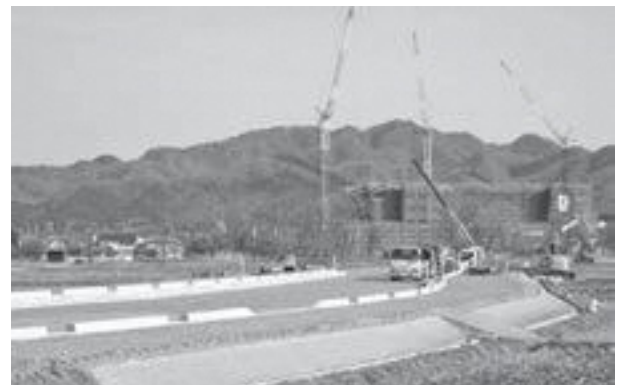
建設中の松山から新村上総合病院へのアクセス道路
