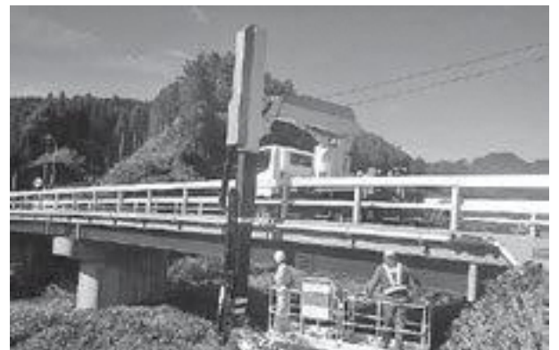
橋梁点検の様子
