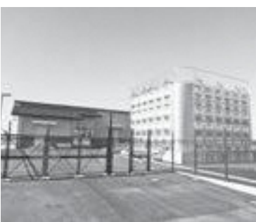
昨年2月から運転開始した荒島浄水場
