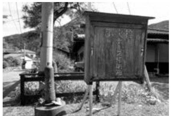
点検・修繕が必要な消火栓
