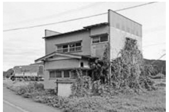
国道に面した管理不全な旧店舗の建物(朝日地区)
