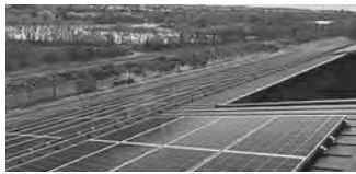
▲し尿処理場アクアセンター にソーラーパネルを設置
