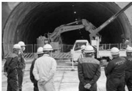
貫通した第1号トンネルの視察
