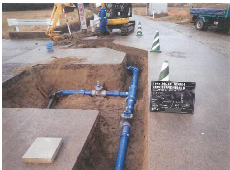
老朽管更新工事
