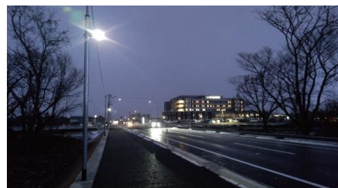
新村上総合病院前のLED防犯灯
