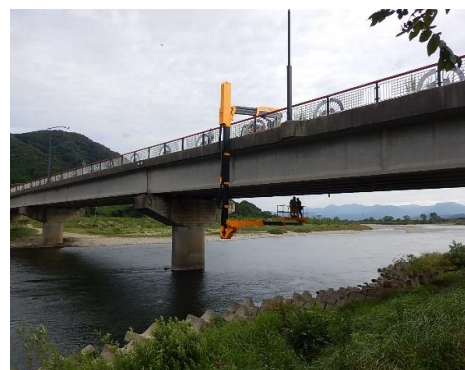
橋りょうの点検状況
