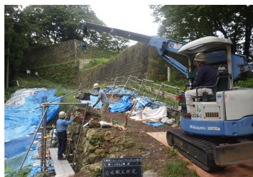
令和2年度の石垣解体工事
