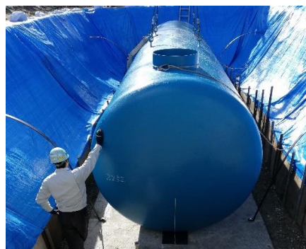
埋設型防火水槽の設置 (R2年度山口地内)
