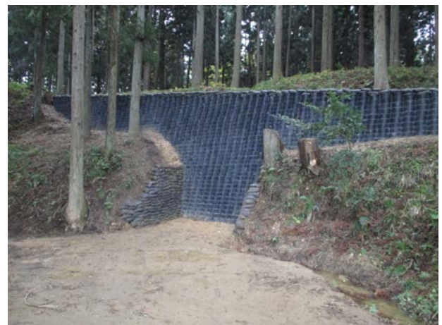
写真8 ジオセル擁壁工法による法面補修（H30）
