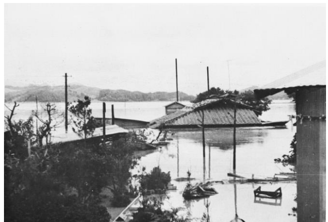
(S42 羽越水害で氾濫した荒川による被害)
