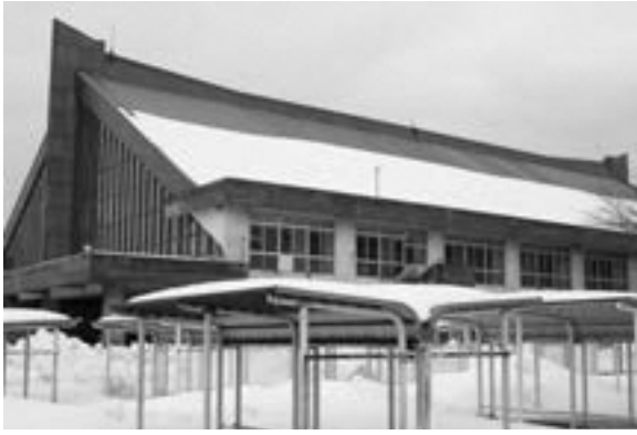
抜本的な屋根の改修が必要(荒川総合体育館)
