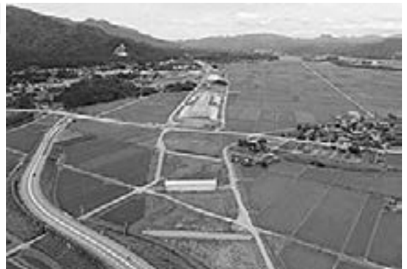
工事着手から8年経過した朝日温海道路(新潟国道事務所提供)
