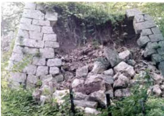
昭和 46 年（1971）豪雨により崩壊した出櫓台石垣北面
