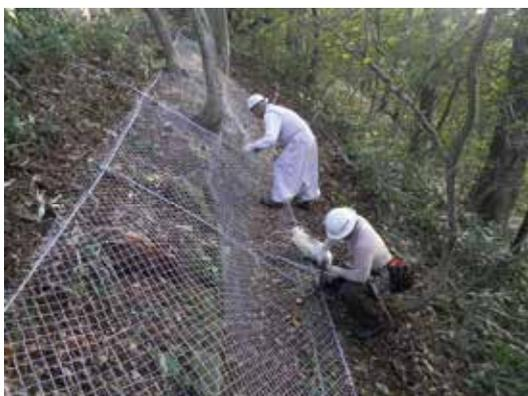
出櫓台跡下西面石垣落石防止金属ネット設置状況
