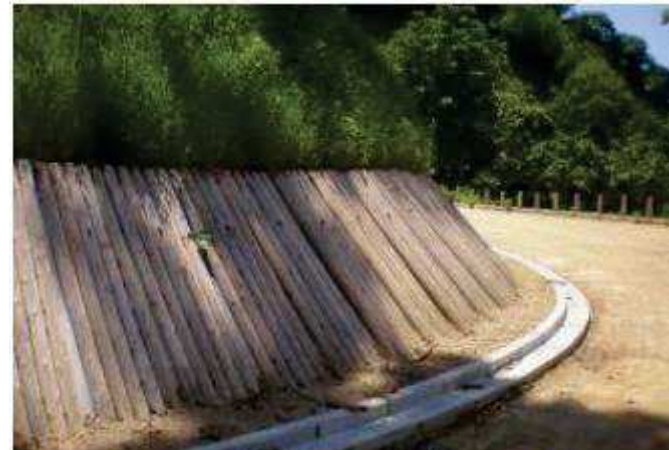
基幹林道 大毎北中線 ※写真は新潟県HPより引用
