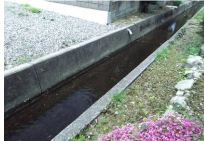
敷地裏の水路
