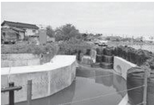
平林地内の滝矢川改修事業現場
