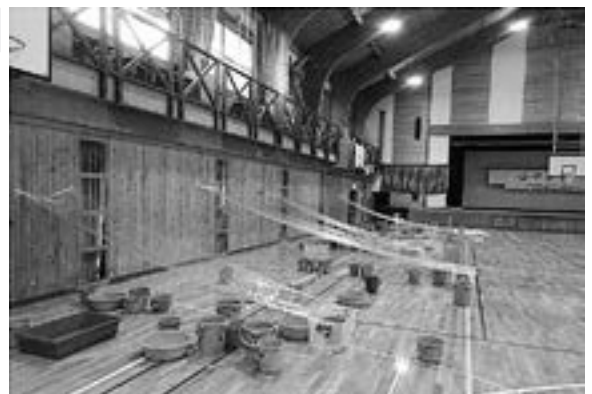
山北中学校の雨漏りの状況
