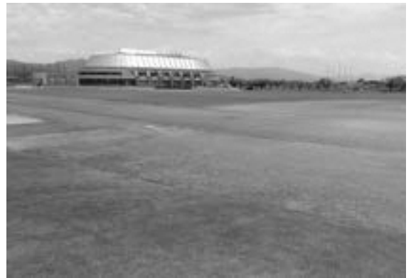
建設を待ち望む人工芝多目的グラウンド
