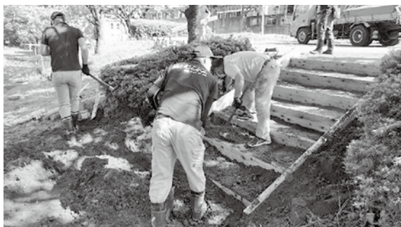
▲階段の枠内に土を入れて固定
