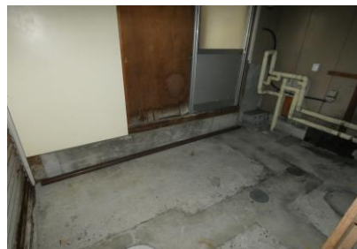
車庫兼物置 (駐車スペース)
