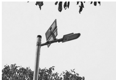
ソーラーシステムの避難路照明(大月地内)
