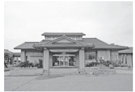
廃止される瀬波デイサービスセンター
