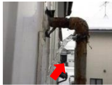
給水管がむき出しになっている
