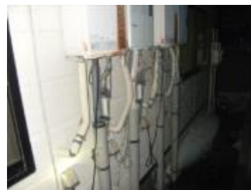
給水管がむき出しになっている
