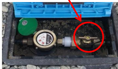
一般向けの止水栓の例
