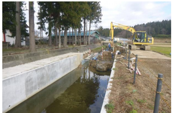
普通河川滝矢川の改修
