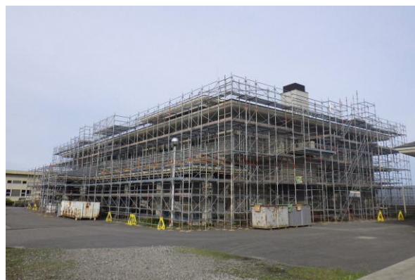
村上浄化センター改築更新工事
