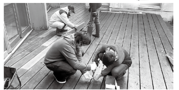
▲劣化した板の張り替え作業
