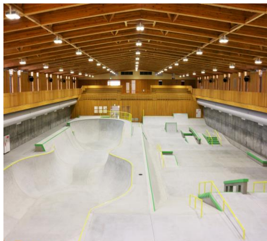
構造材および仕上げ材に村上市産杉材を使用している（村上市スケートパーク）
