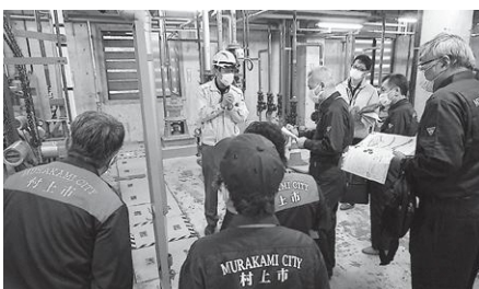
浸出水の処理について説明を聞く
