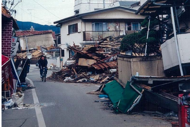
〔図 4.3 地震後の道路閉塞の状況〕
