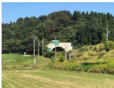
写真 45 山元トンネル
