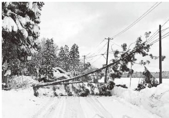
広範囲に発生した倒木でかつてない被害に
