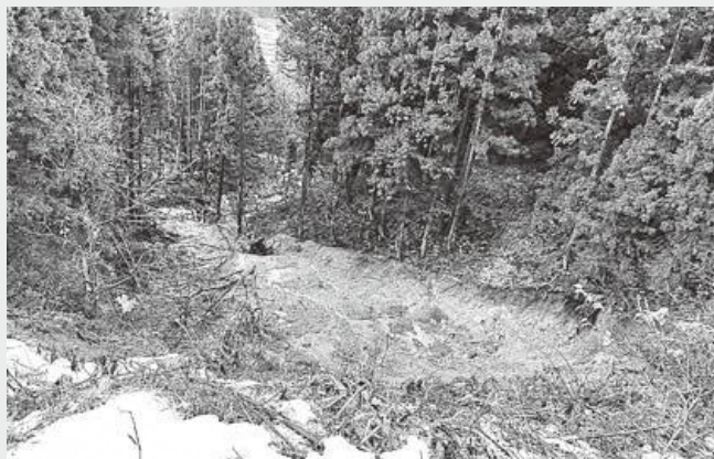
初級者コース（グレープロード）脇の土砂災害
