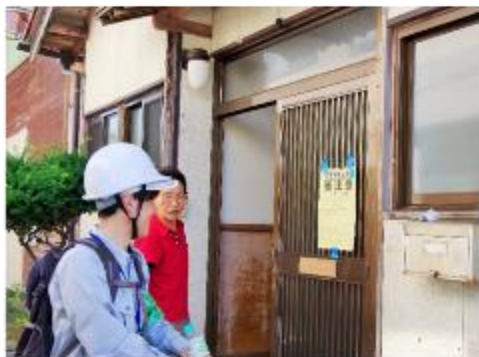
▲府屋地内（駅前通り） 被災建築物応急危険度判定調査
