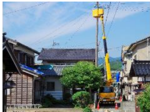
▲府屋地内（駅前通り）建物被害状況
