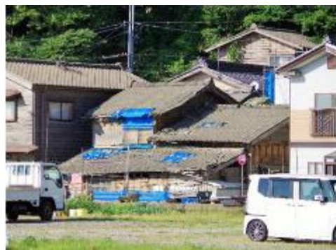
▲鶴泊地内建物被害状況
