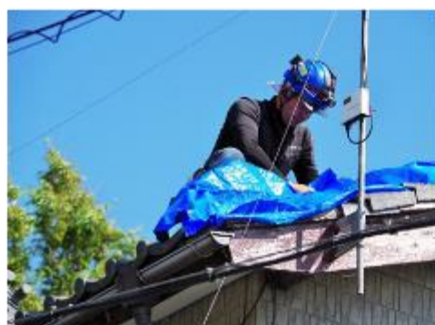
▲ボランティアによるブルーシート張り
