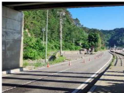
▲国道 345 号弘法トンネル付近の落石
