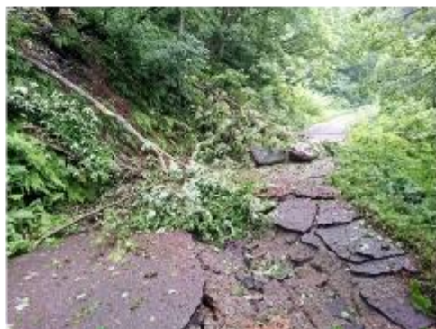
▲林道平床線（高根地内）
