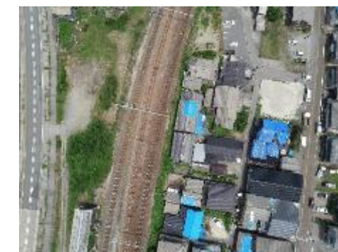
▲府屋地内（駅前通り） ドローンによる空撮画像
