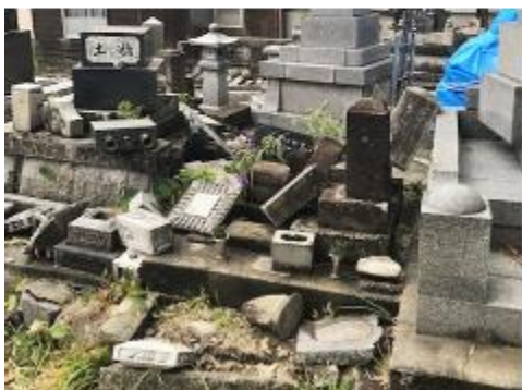
▲府屋上山墓地倒壊状況
