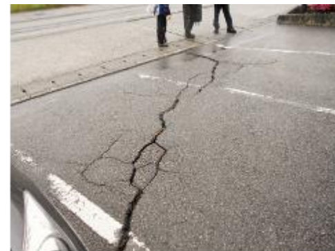
▲府屋地内（本町）郵便局駐車場
