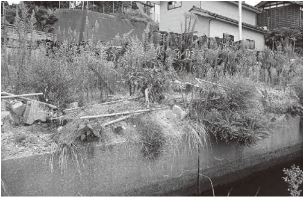
用水路のフェンスなどの復旧工事は秋以降に
