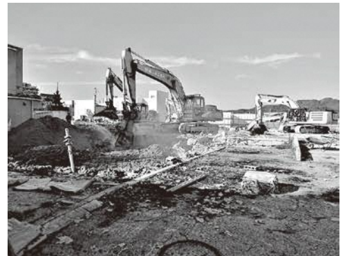
解体工事が進む旧村上総合病院跡
