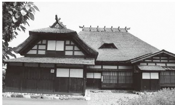
再建できないか。令和3年3月に火災で消失した「またぎの家」
