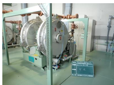
村上浄化センター汚泥脱水機更新工事
