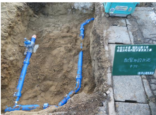
水道管路更新工事
