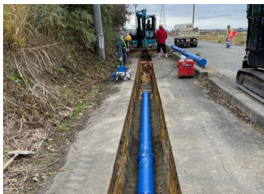
水道管路更新工事
