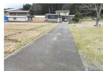
前面道路の様子
