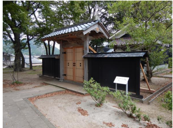
写真 「間部詮房御霊屋御門」扉、基礎部などの修理
