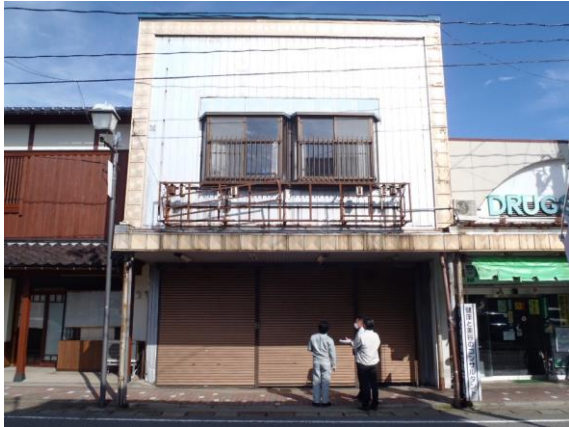
修理・修景前
