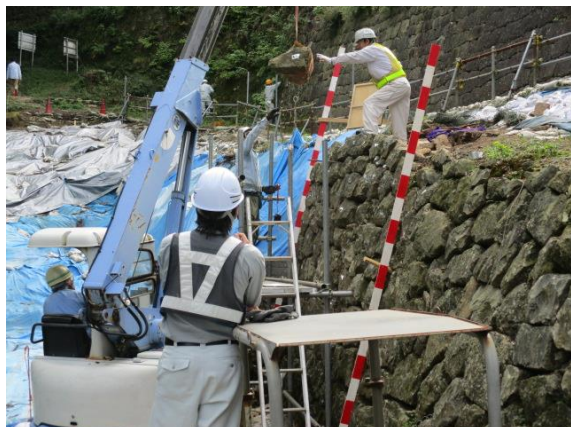
黒門跡石垣解体の様子
