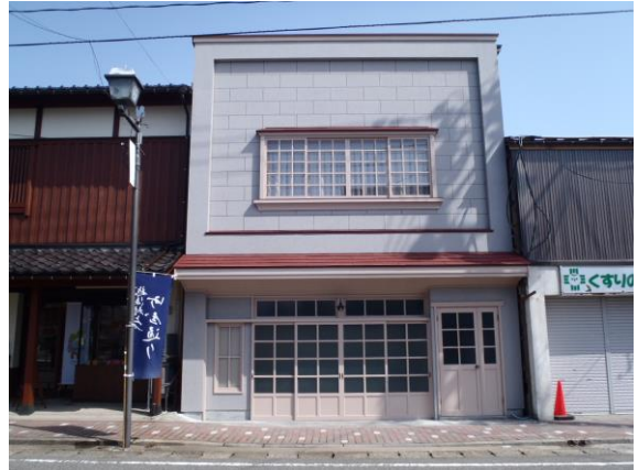
修理・修景後
