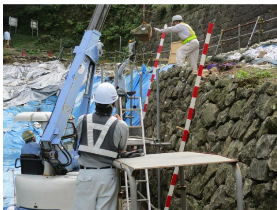
石垣修復工事の様子
