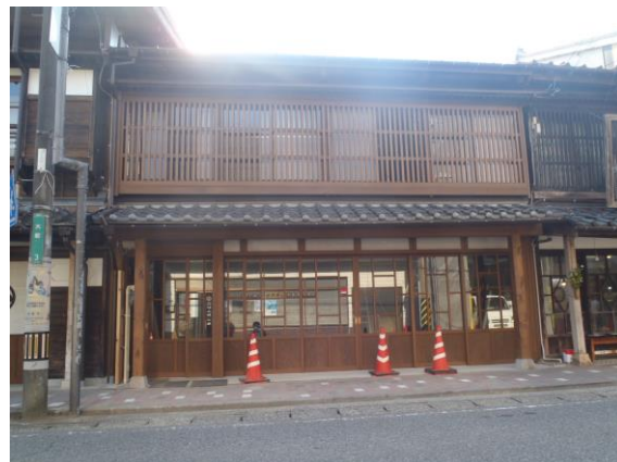
修理・修景後
