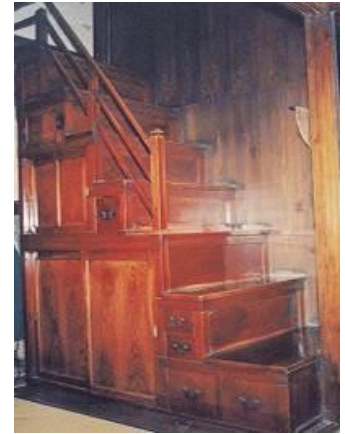
図 町家内部の箱階段
