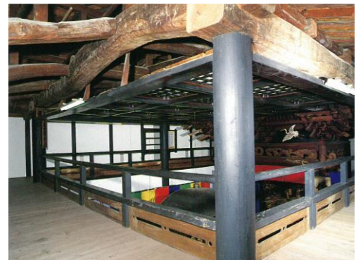
図 浄念寺本堂二階の廻廊
