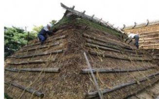
茅葺屋根の葺き替え
