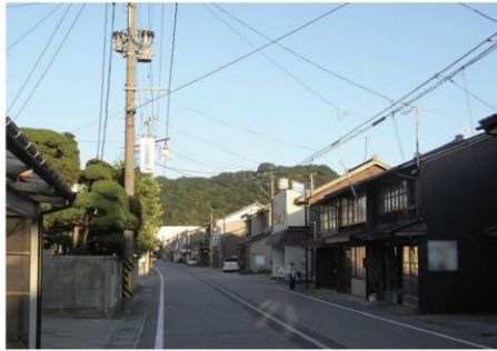
歴史的町並みを阻害する電柱・電線
