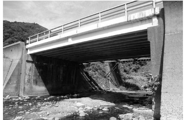
修繕補強工事が行われる今川橋
