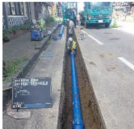
▲水道の老朽管を計画的に更新します
