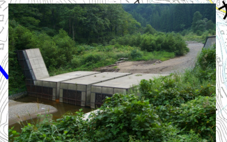
西大鳥川第一砂防堰堤
