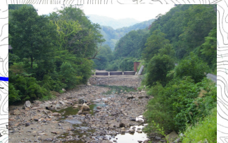
西大鳥川第二砂防堰堤
