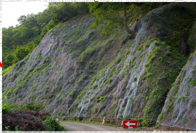
落石防止工事箇所
