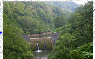
鰻沢砂防堰堤
