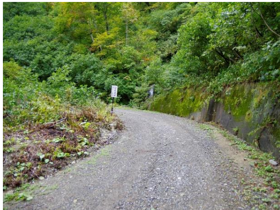
シミズ沢付近未舗装部（鶴岡市）
