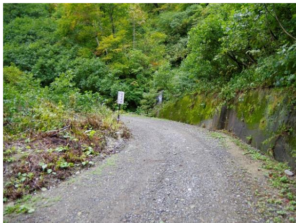
シミズ沢付近未舗装部（鶴岡市）
