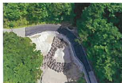
令和2年5月復旧工事後
