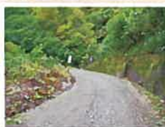
シミズ沢付込未舗装部（鶴岡市）
