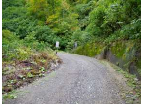
シミズ沢付近未舗装部（鶴岡市）
