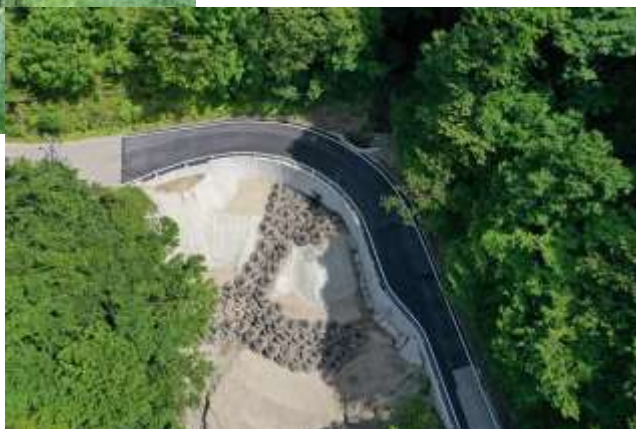
令和2年5月復旧工事完了（村上市）
