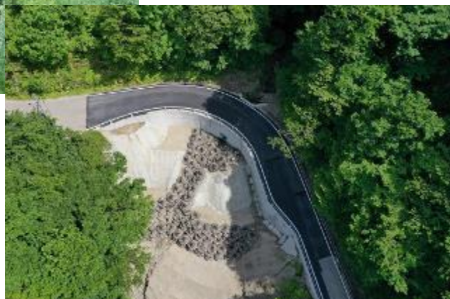
令和2年5月復旧工事完了（村上市）
