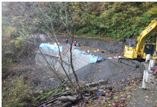
災害復旧工事状況(R4災 8.2kp)
