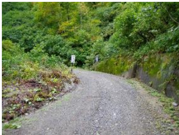
シミズ沢付近未舗装部（鶴岡市）
