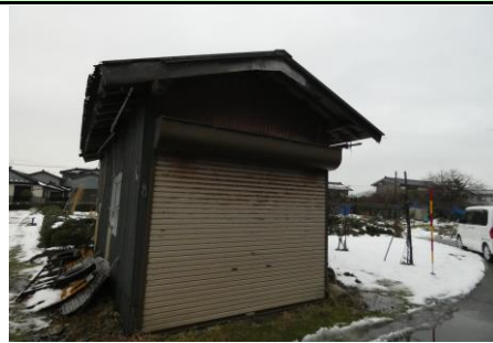
車庫(道路向かい)
