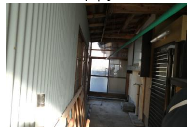
居宅と物置の接続部
